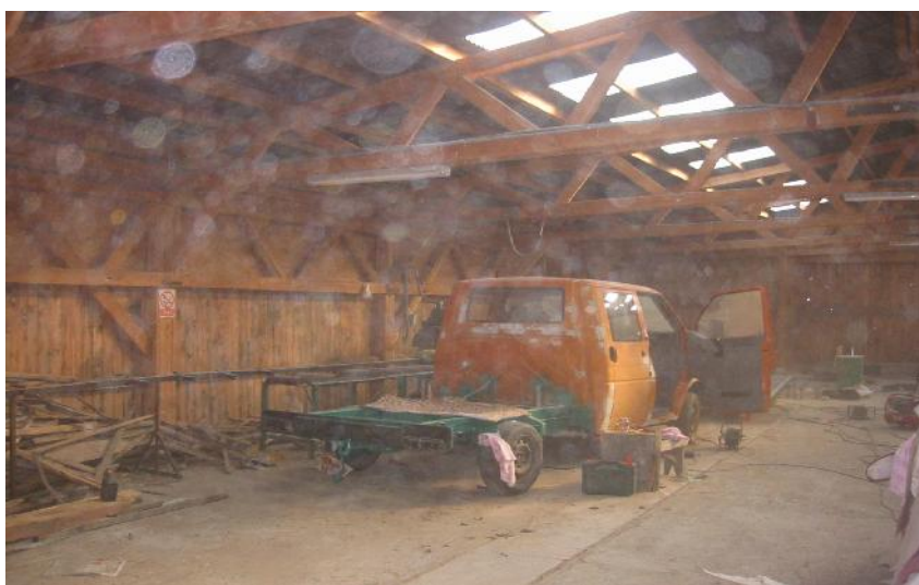
Vedere interior constructie din lemn
