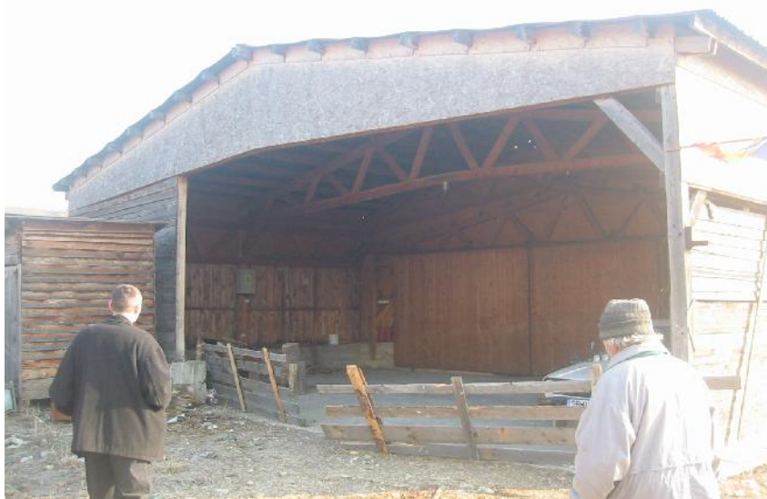
Vedere frontala constructie usoara din lemn
