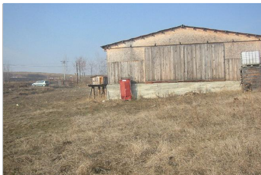
Vedere din spate constructie din lemn
